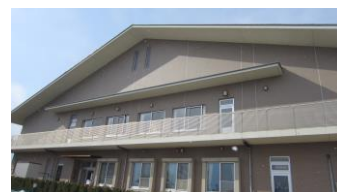
特養 3F 外壁タイル工事
