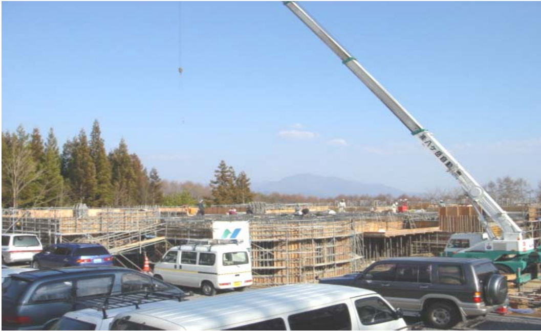
【第二仁生園建設工事の様子】
